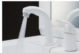
洗面器具の更新 (ジョイ尾山台)
