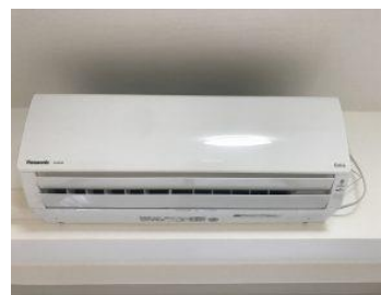
省エネ型エアコンの設置 (TKフラッツ渋谷)
