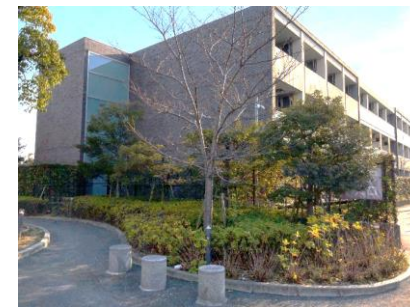
自主管理公園の設置 (グランカーサ緑地公園)
