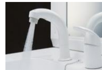
節水型洗面器具への更新 (ジョイ尾山台)
