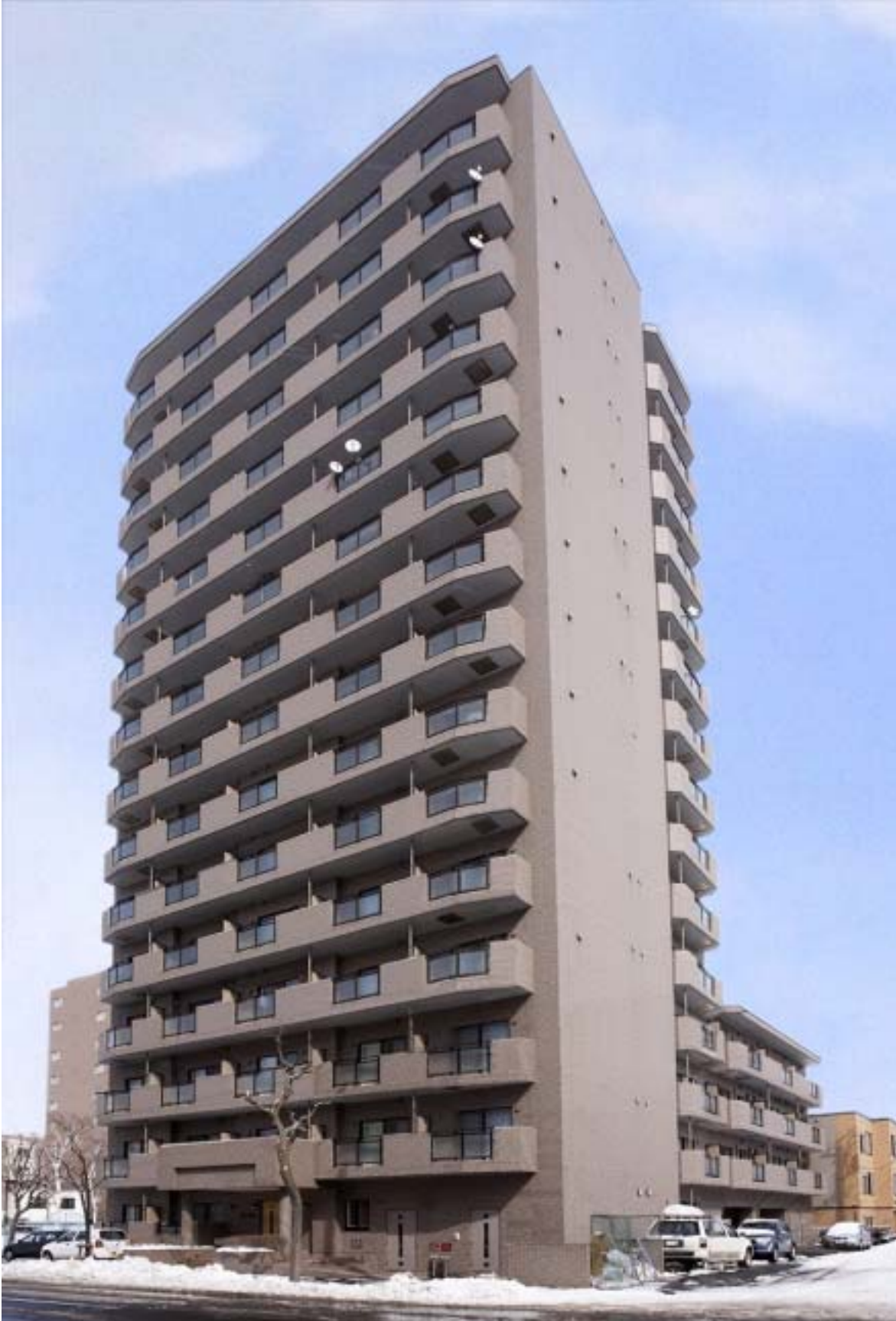
スカイヒルズ N15 外観写真
