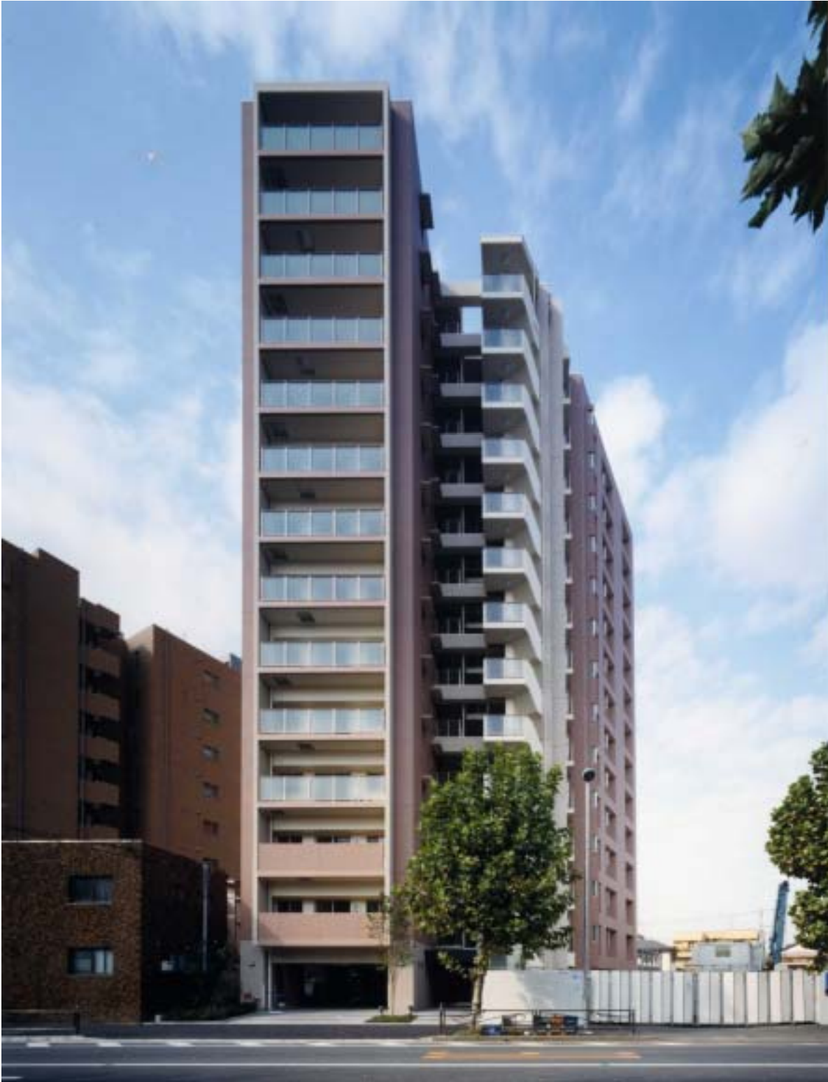
外観写真 《(1)プロスペクト川崎》
