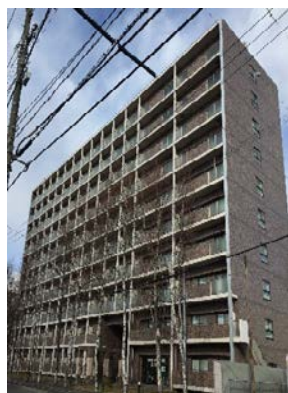
スカイヒルズ栄町 (北海道千歳市 2002年竣工) 工事費 85百万円
