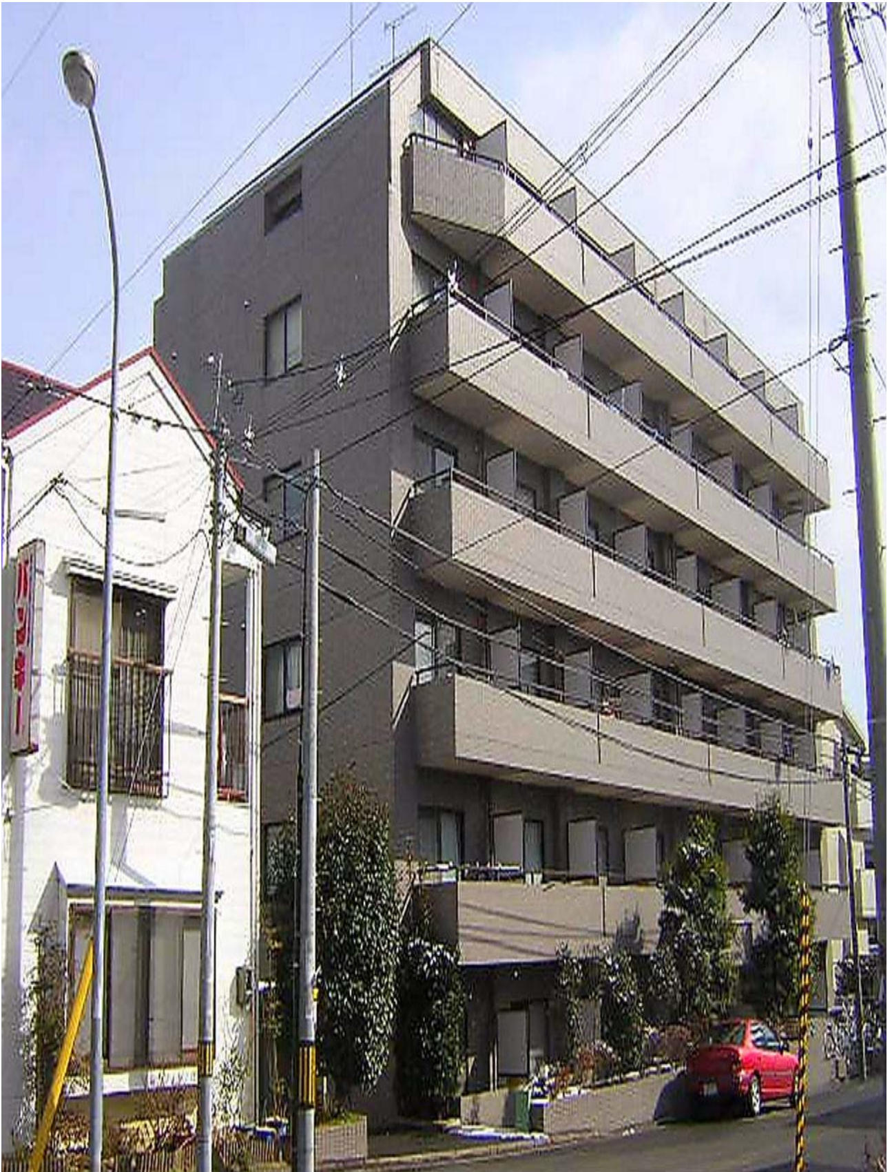
外観写真《リビングステージ東仙台》
