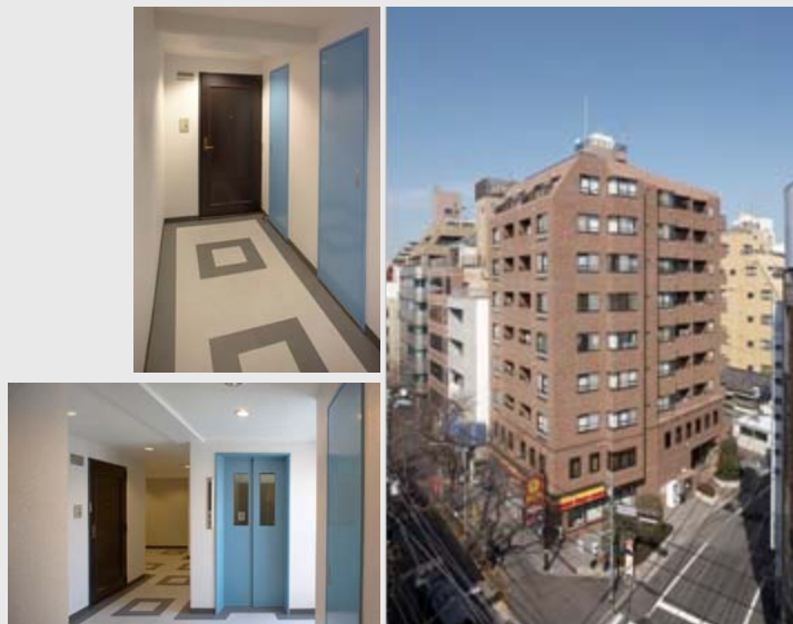
大規模修繕完了後
