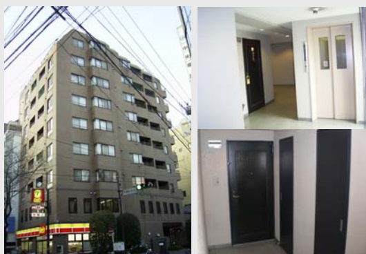
大規模修繕実施前
