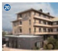
20 アルファリビング 岡山後楽園 岡山県岡山市
