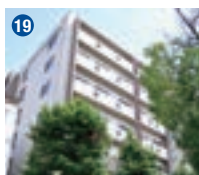
19 アルファリビング 岡山西川緑道公園 岡山県岡山市
