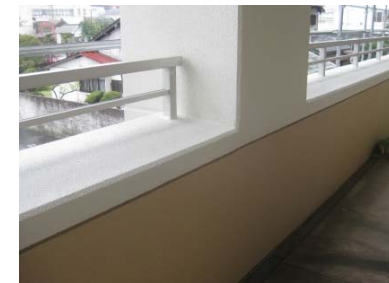
<手摺壁(施工後)>
