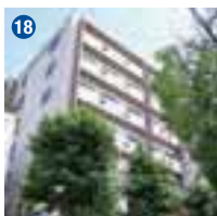
*アルファリビング 岡山西川緑道公園 岡山県岡山市
