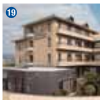
*アルファリビング 岡山後楽園 岡山県岡山市
